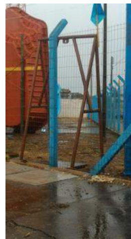
Estação elevatória Trevo
