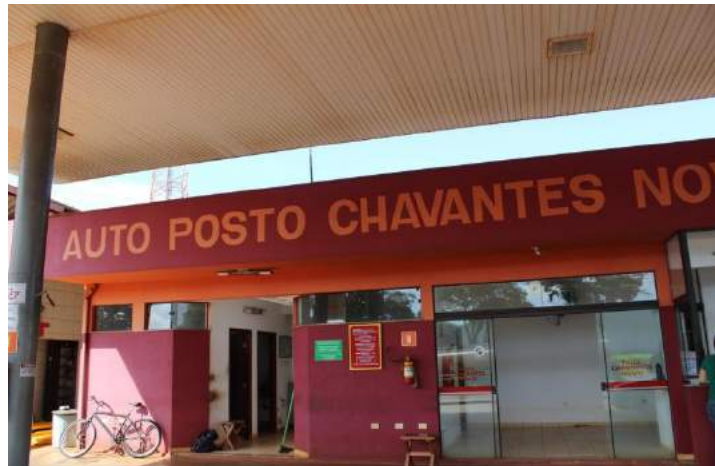
Posto de combustíveis localizado na Avenida Antônio Fontes, realiza com esmero a disposição local de recipientes e limpeza do filtro
