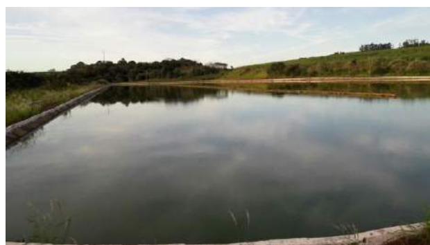
LAGOA DE TRATAMENTO
