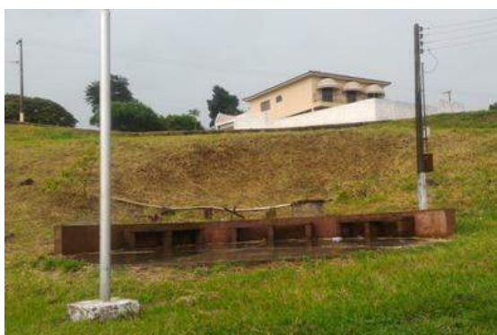
Estação elevatória Paineira
