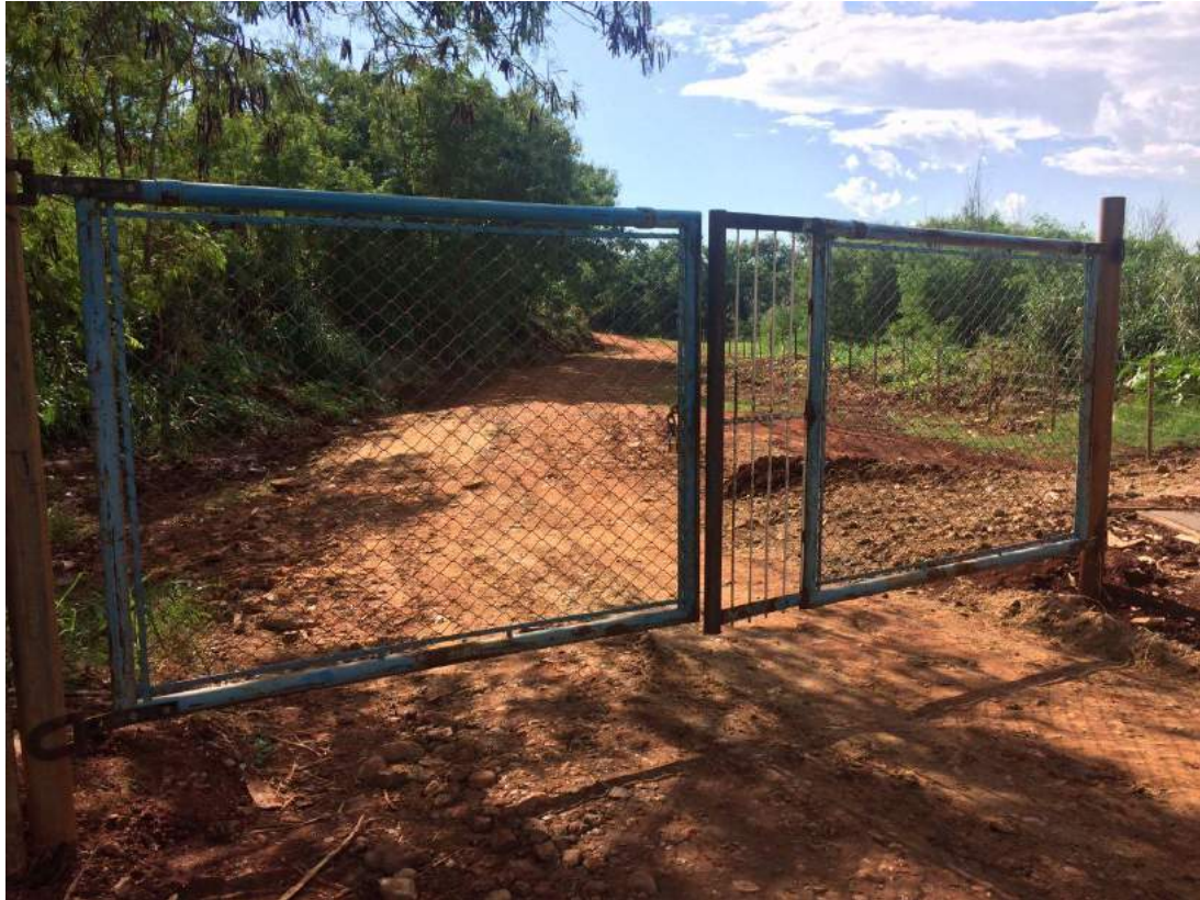
Foto da entrada do aterro sanitário em valas municipal.
