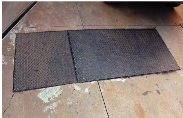
Local onde se encontra o filtro
