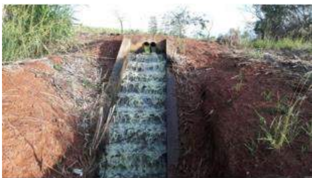
Tubulação de saída do esgoto Encaminhamento para o corpo receptor
